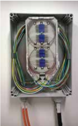
Kuva 2.34. Esimerkkejä asennetuista sisäjatkoskaapeista (Kuvat DNA Oyj, Nestor Cables Oy).
