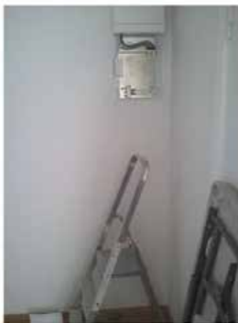
Kuva 4.14. Liian pieni tai jopa olematon työvara tekee kaapelin päättämisen hankalaksi tai jopa mahdottomaksi.
