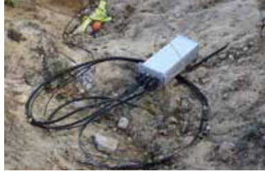
Kuva 2.37. Asennettuja ulkojatkoskoteloita (Kuvat Nestor Cables Oy).
