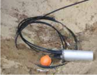
Kuva 2.37. Asennettuja ulkojatkoskoteloita (Kuvat Nestor Cables Oy).
