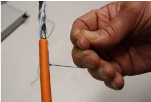
Kuva 4.22. Kaapelin päättäminen päätepaneeliin, vaihe 2.
