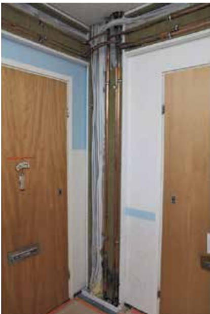
Kuva 4.12. Kaapeleita asennettuna johtotielle.
