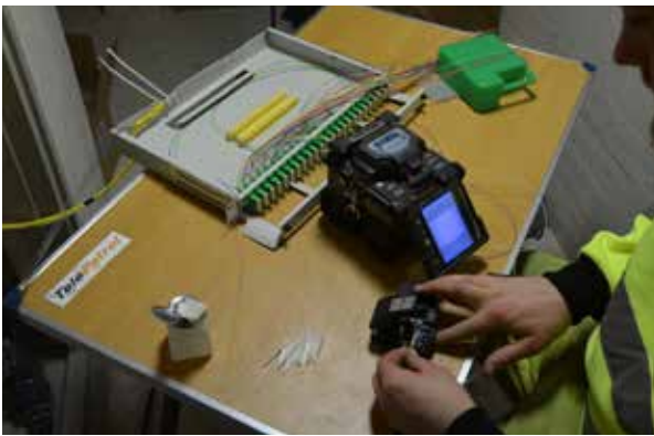
Kuva 4.29. Nousukaapeleiden päättämistä talojakamon päätepaneeliin (Kuva: TelePatrol Oy).
