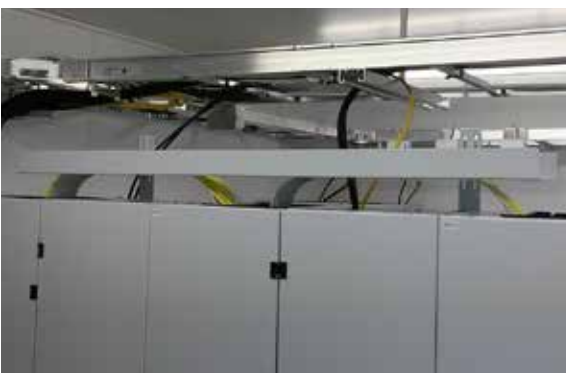
Kuva 2.30. Esimerkki optisten kytkentäkaapeleiden johtotiejärjestelmästä (Nestor Cables Oy).
