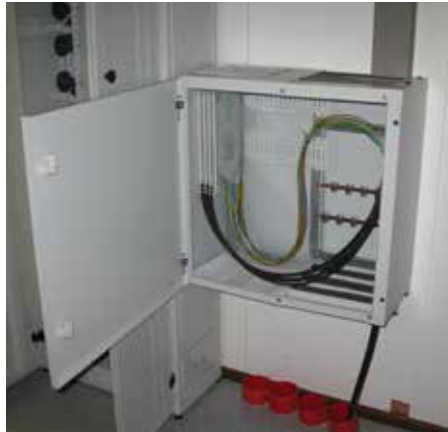
Kuva 2.34. Esimerkkejä asennetuista sisäjatkoskaapeista (Kuvat DNA Oyj, Nestor Cables Oy).
