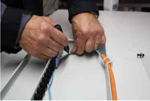
Kuva 4.23. Kaapelin päättäminen päätepaneeliin, vaihe 3.
