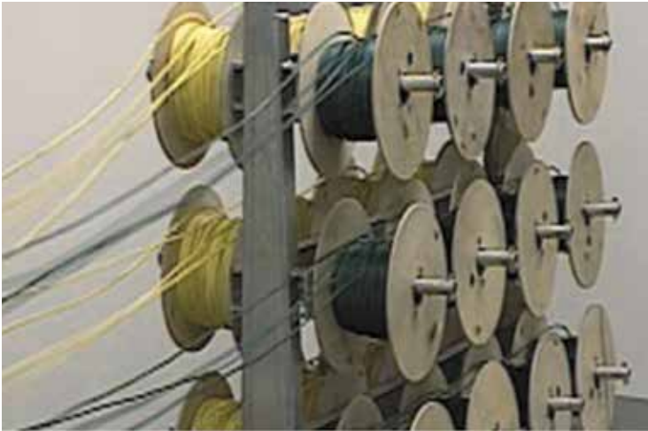
Kuva 4.11. Usean kaapelin samanaikainen asennus.
