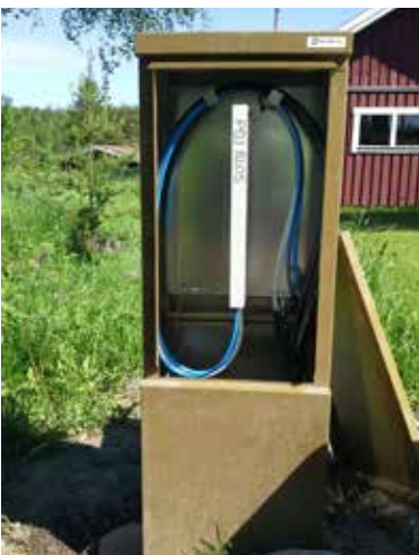
Kuva 2.38. Jatkoskaappeja asennettuna (Kuvat Empower Oy).
