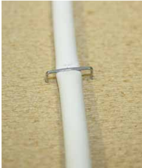
Kuva 4.8. Liian kireät nippusiteet tai kiinnikkeet aiheuttavat haitallista puristusta kaapeleihin.
