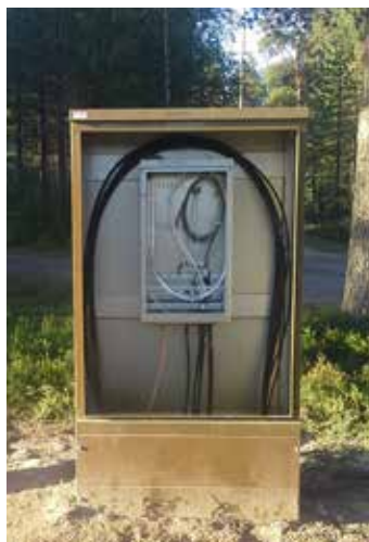
Kuva 2.38. Jatkoskaappeja asennettuna (Kuvat Empower Oy).
